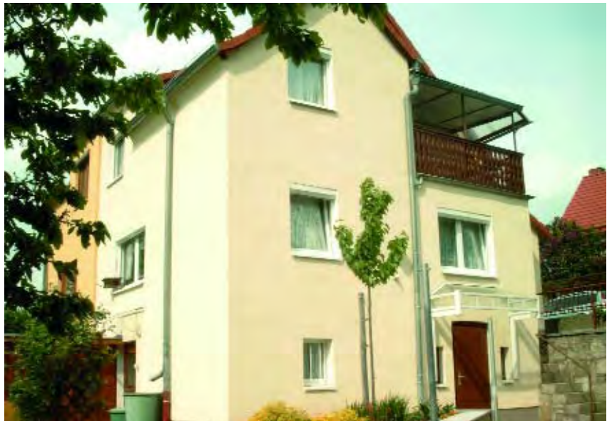
Bild 1: Um 1935 erbautes und nun renoviertes Doppelhaus in Jena
