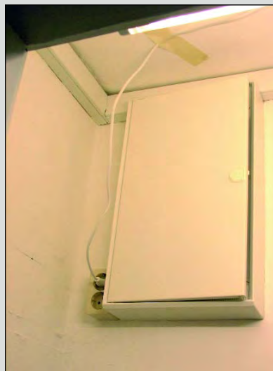
Einerseits ein bärenstarker Wohnungsanschluss zum gleichzeitigen Speisen zweier Durchlauferhitzer in einfachen Altbau-Mietwohnungen in Hamburg (li.) und andererseits weder Leuchte noch Lichtschalter für den Abstellraum samt der darin angeordneten Verteilertafel (re.)
