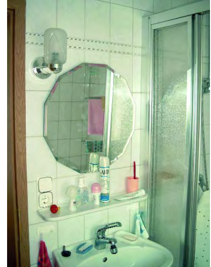
Bild 8: Die Leuchte musste versetzt werden, zuvor befand sie sich rechts vom Spiegel und somit zu dicht an der Dusche
