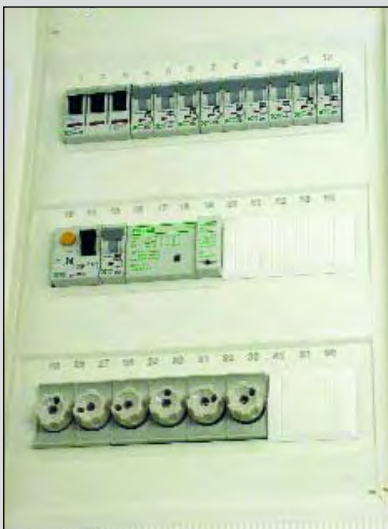
Einerseits ein bärenstarker Wohnungsanschluss zum gleichzeitigen Speisen zweier Durchlauferhitzer in einfachen Altbau-Mietwohnungen in Hamburg (li.) und andererseits weder Leuchte noch Lichtschalter für den Abstellraum samt der darin angeordneten Verteilertafel (re.)
