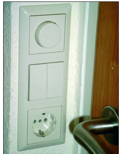
Bild 15: Arbeitsaufwändig, aber Platz sparend die Montage in der Türleibung: So muss für Lichtschalter (li.) und Steckdosen (re.) kein Stück Wand frei gehalten werden
