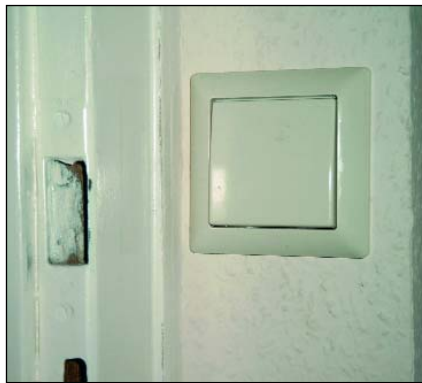
Bild 15: Arbeitsaufwändig, aber Platz sparend die Montage in der Türleibung: So muss für Lichtschalter (li.) und Steckdosen (re.) kein Stück Wand frei gehalten werden
