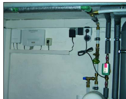
Bild 19: Dort, wo ohnehin ein Gerät erforderlich ist, um den Haus-Übergabepunkt der Telekom zu einem DSL-Anschluss zu machen, sollte man gleich ein Haus internes Netzwerk beginnen lassen
